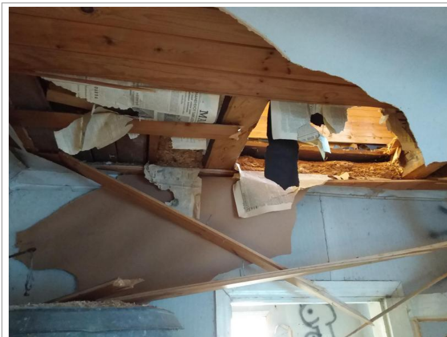
Näyte 2. Asuinrakennuksen rakenteissa olevan tervapaperin PAH-pitoisuus ylittää vaarallisen jätteen raja-arvon.
