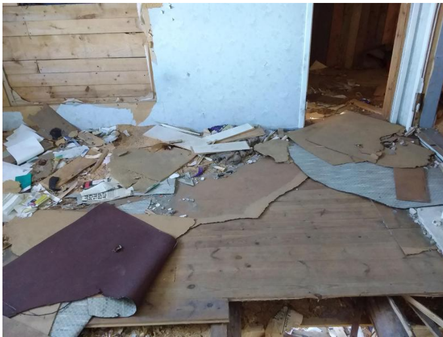
Näyte 4, yläkerran lattian muovimatot ei sisällä asbestia.
