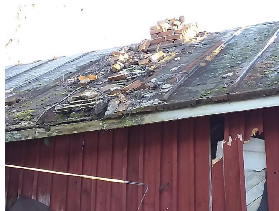
Näyte 1, asuinrakennuksen vesikaton bitumikermi ei sisällä asbestia eikä haitta-aineita.
