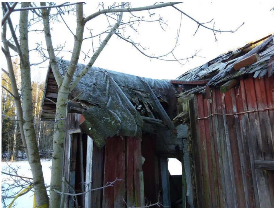
Näyte 7, ulkorakennus 1 vesikaton bitumikermi ei sisällä asbestia eikä haitta-aineita.
