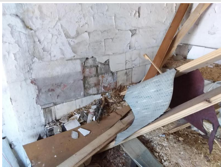
Näyte 5, asuinrakennuksen muurin laatoitus, kiinnityslaasti ja tasoite ei sisällä asbestia.
