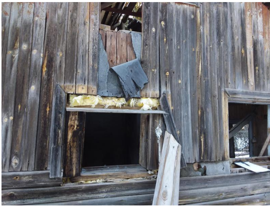
Näyte 8, ulkorakennus 1 saunan pään seinien bitumikermi ei sisällä asbestia eikä haitta-aineita.
