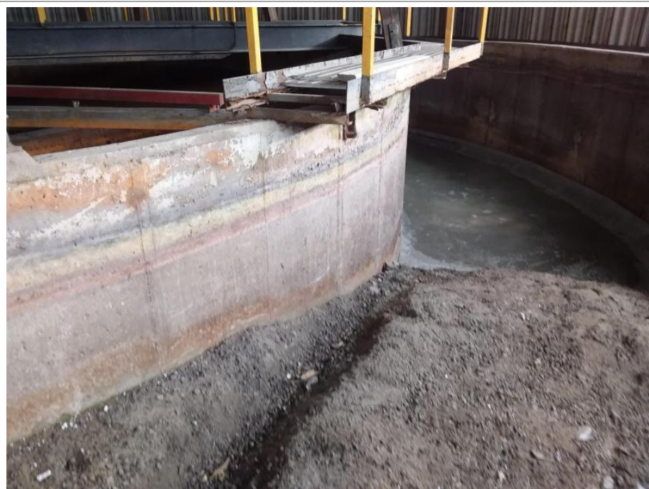
Altaan betonin pinta massasta otettu näyte1, ei sisällä asbestia.
