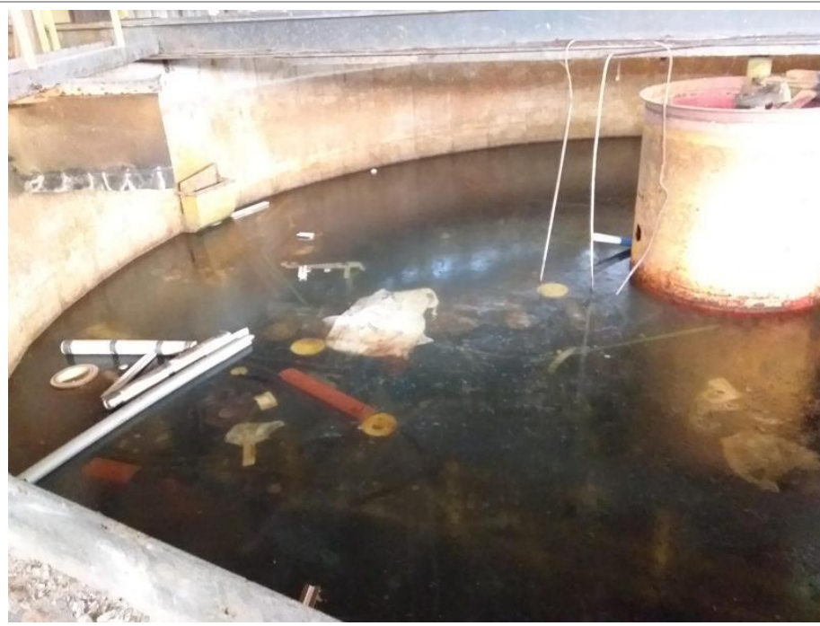
Altaan betonin pinta massasta otettu näyte 1, ei sisällä asbestia.
