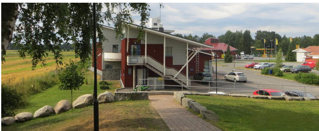
Kirjastorakennus, oikealla liikerakennukset pysäköintialueineen. (Valokuva: Google Maps)
