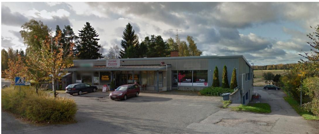
Liikerakennus Kirkkotien varressa. (Valokuva: Google Maps)
