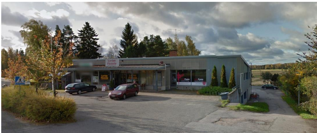
Liikerakennus Kirkkotien varressa. (Valokuva: Google Maps)
